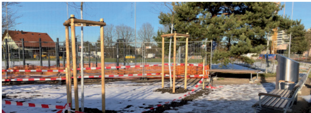
Die kleine Fitnessanlage auf der Nordseite ist fertig erstellt.
