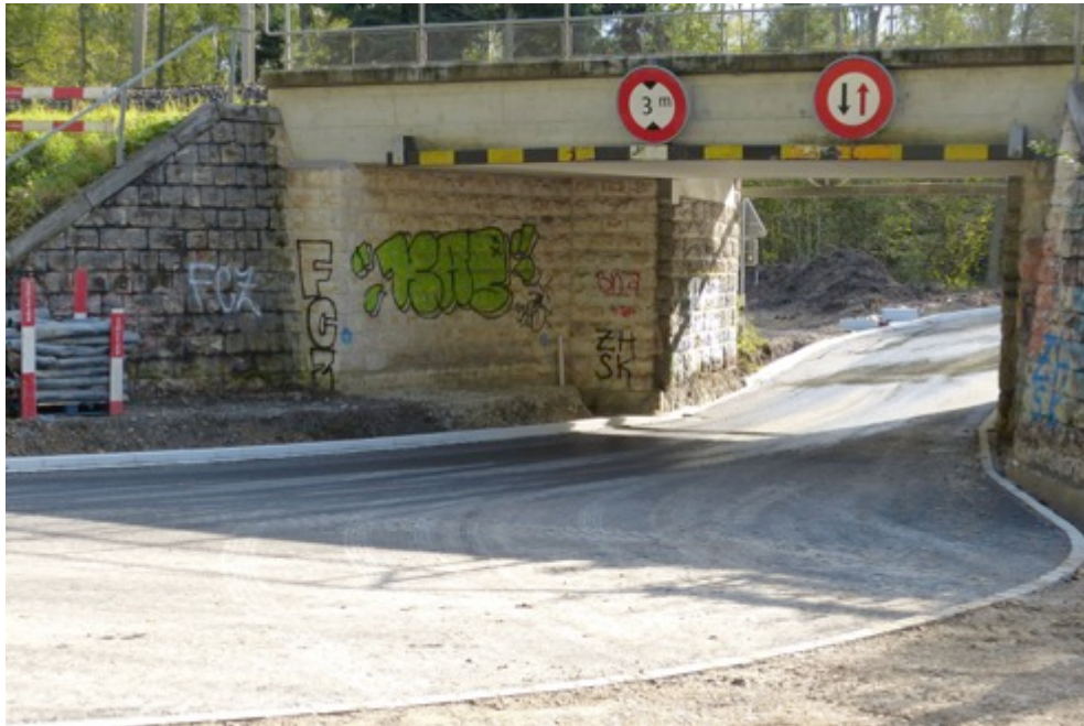
Situation nördlich der Unterführung (ausgebaute Kurve).
